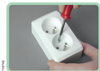
P116749 Csavarozza ki a rögzítőcsavart.
